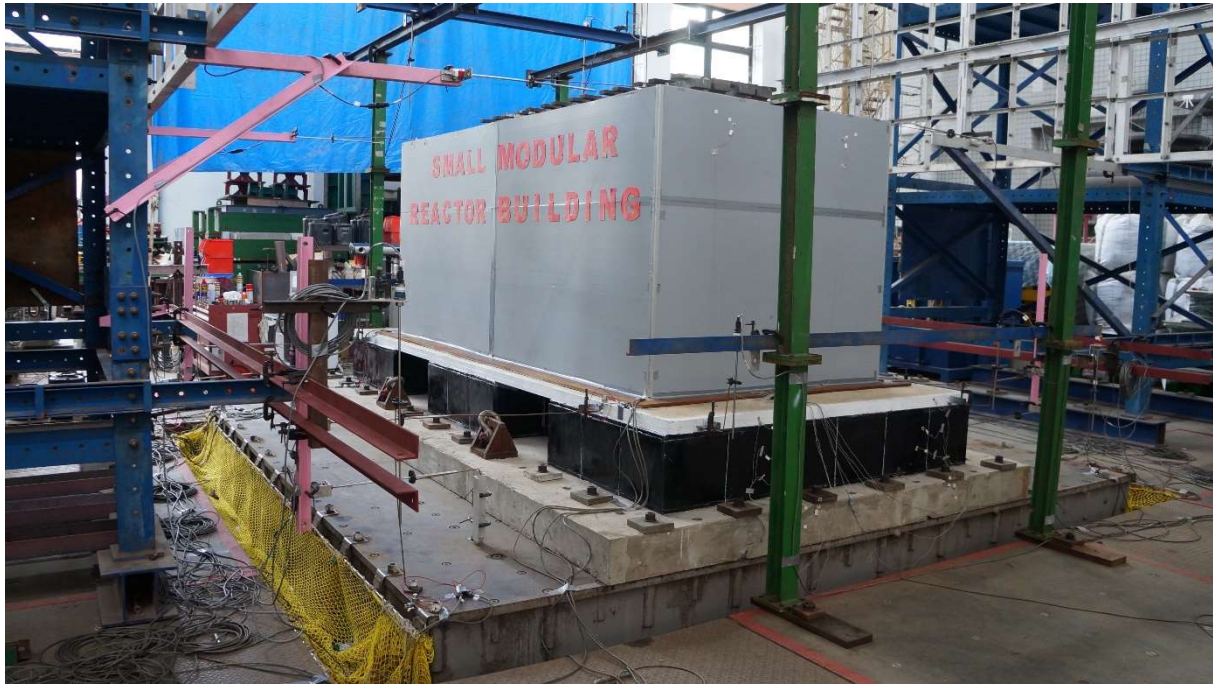
圖 12 全試體安裝完成
